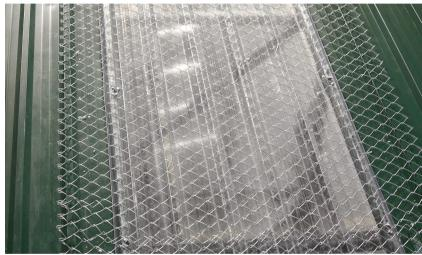
Nuestro sistema de fijación de la malla, mediante cinta perforada (Inox AISI-316) y remache tipo trébol con doble junta tórica, está ideado para evitar problemas por filtraciones de agua.
