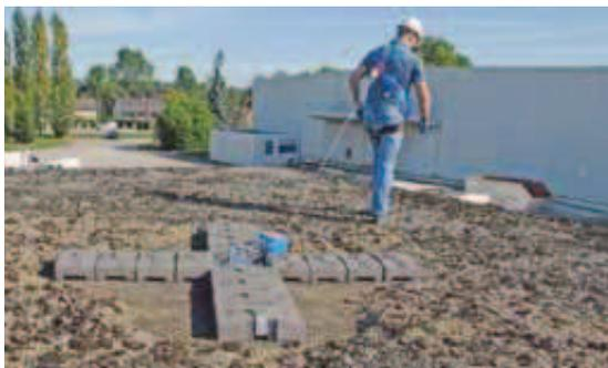
El MOBIFOR™ está compuesto de 16 pesos de 22 kgs cada uno, fabricados en hormigón y partículas de acero.
