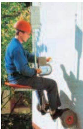
**Silla de reducidas dimensiones equipada con aparejo de elevación SCAFOR**
