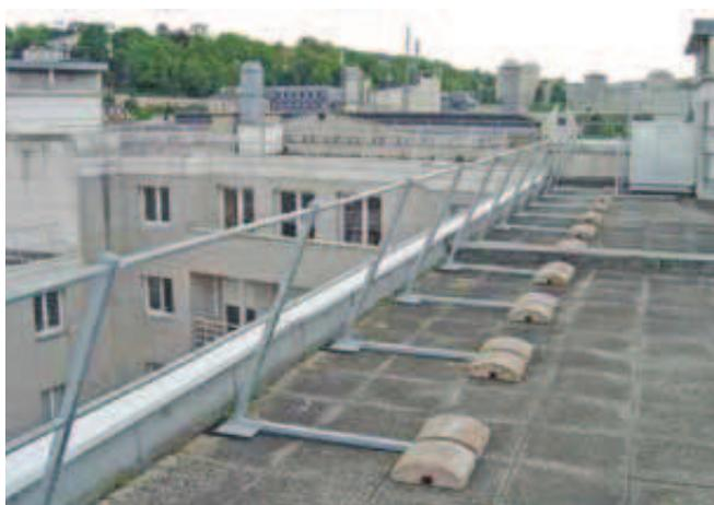
El sistema de guarda rail Autoportante de TRACTEL® se adapta a todas a las configuraciones de cubierta. El sistema esta diseñado para ser instalado en cubiertas nuevas y existentes.
